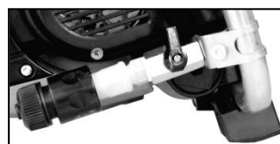
El suministro de agua cerrado (palanca de la válvula horizontal)
